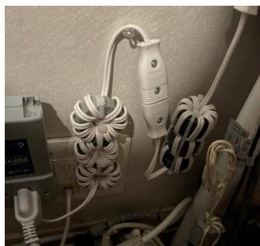
近隣に出来た太陽光発電から電灯線を通じて入ってくるであろうコモンモードノイズを極力軽減する為にシャックの電源の入り口に 2 台直列で設置しました。
