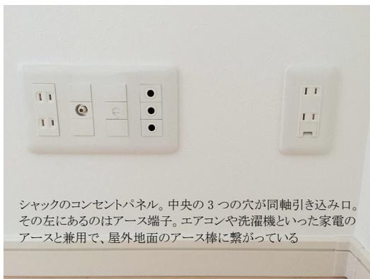
シャックのコンセントパネル。中央の 3 つの穴が同軸引き込み口。その左にあるのはアース端子。エアコンや洗濯機といった家電のアースと兼用で、屋外地面のアース棒に繋がっている
