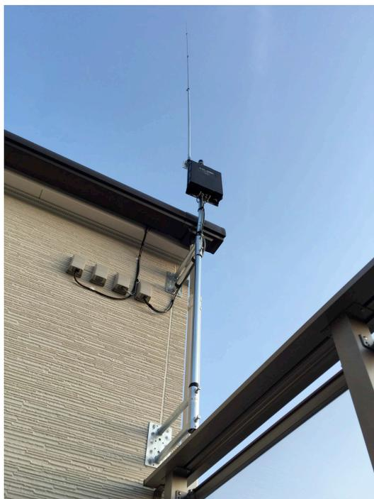
AW-M01/520 は、V 型 DP RDL-2000 の片側エレメントだけを使った ATU 専用エレメント・セット。5.2m 1.3kg と軽量コンパクトで、耐風速は 30 m/sec。強風の日には細いエレメントがしなり、シャック内では突出し金具を伝って風切り音が聞こえる（屋外では聞こえない）。給電点の地上高は約 6.5m。施工の様子はこちら (<http://blog.goo.ne.jp/kitsukawa116/e/579e808fc3dddbc4d7ee8a9f05ccd798>)
