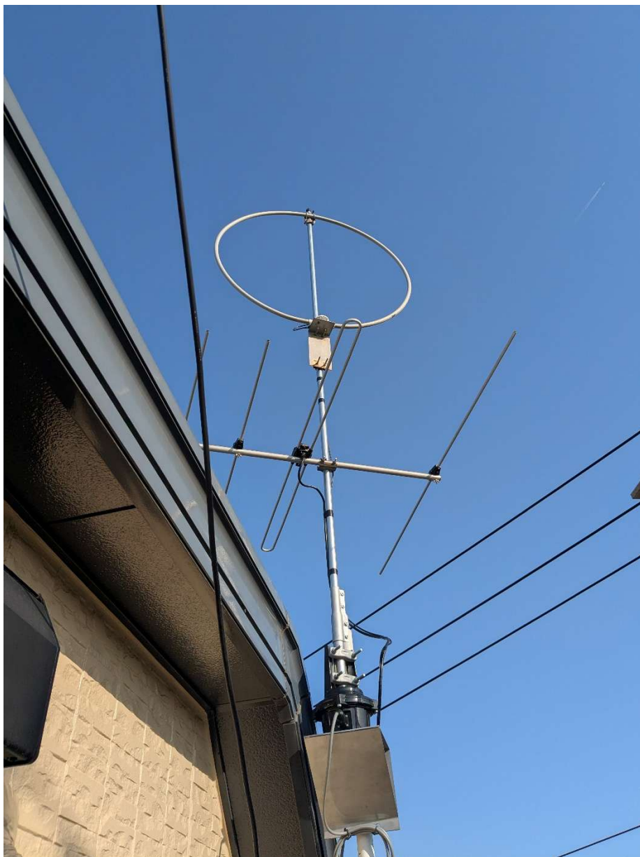
After〜移設後のアンテナの様子。取付位置が高くなりまたマストも長くなり、軒スレスレだったループの位置が 2m 程高くなった。
